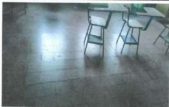
Foto1: Cambio de piso a las aulas de estudio y dirección y bodega.
