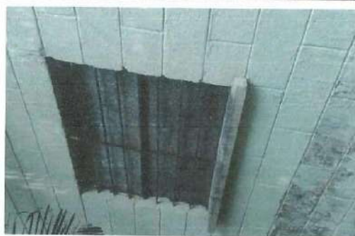
Foto 3: Instalación de balcones de metal, Dirección y bodega.
