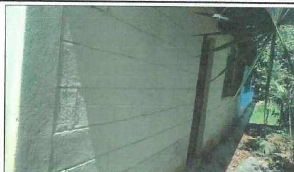
Foto 2: Realización de pintura completa en la EORM.
