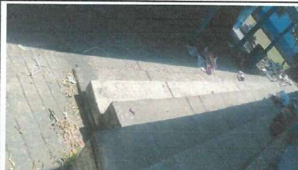
Foto 4: Instalación de cuneta y regilla
